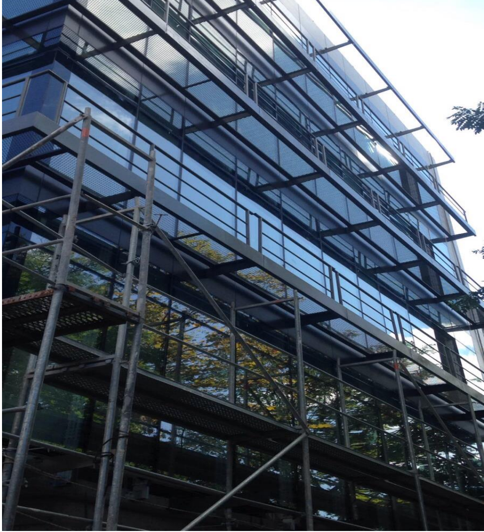
Beşiktaş Kampüs İnşaatı
