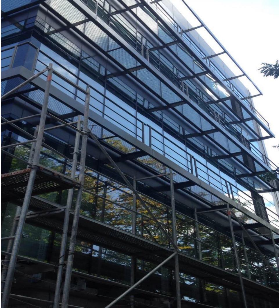
Beşiktaş Kampüs İnşaatı
