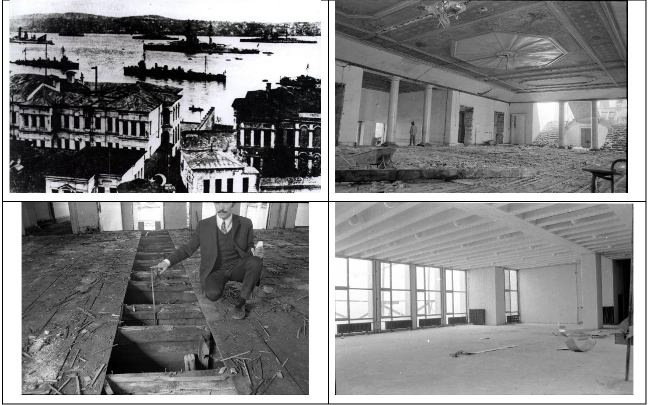
Şekil 1. Yapı ile ilgili fotoğraflar ve betonarme döşeme.
