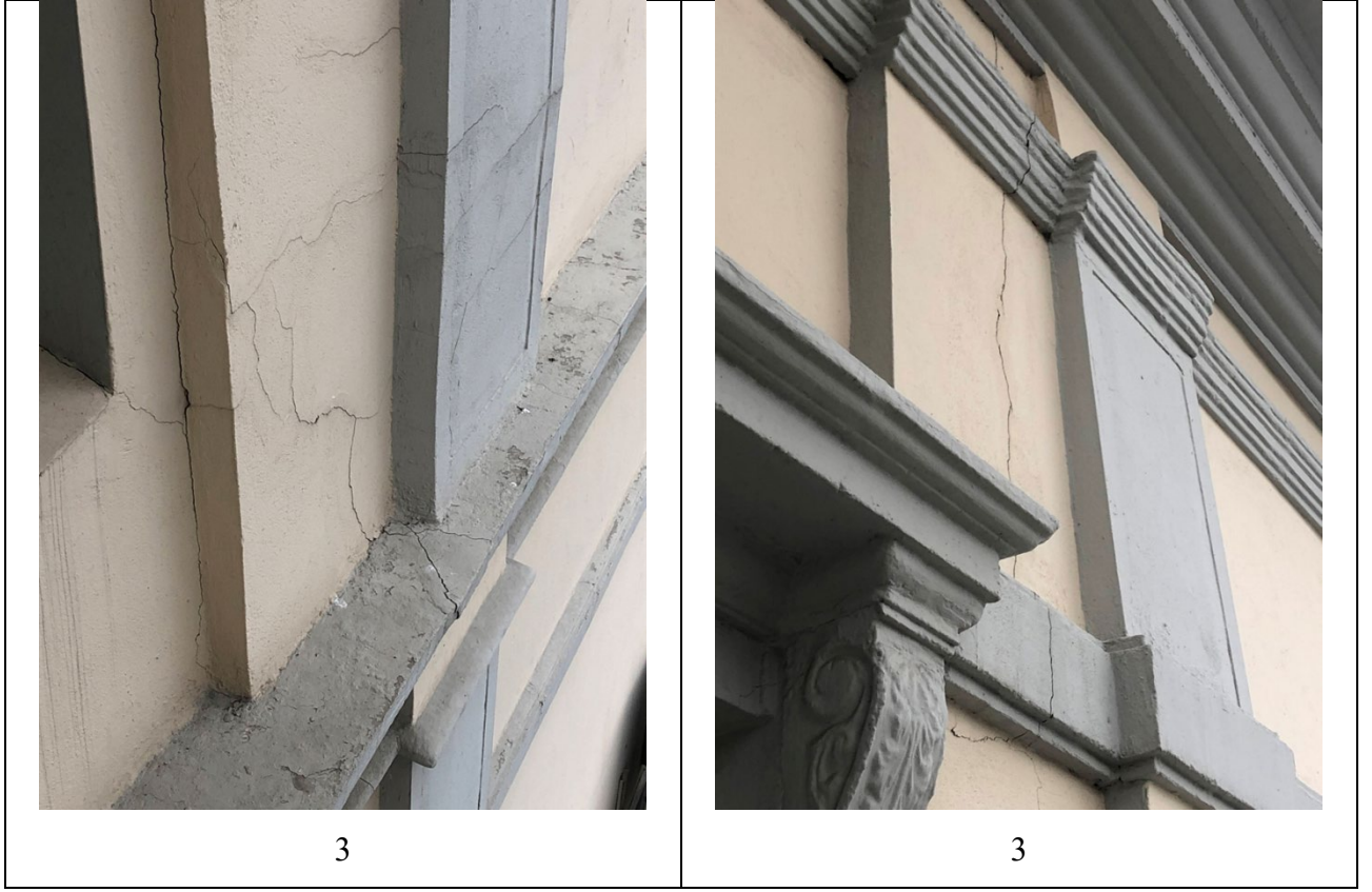
Şekil 8. Restorasyon Anabilim Dalı yan cephe (Denizcilik İşletmeleri tarafı).
