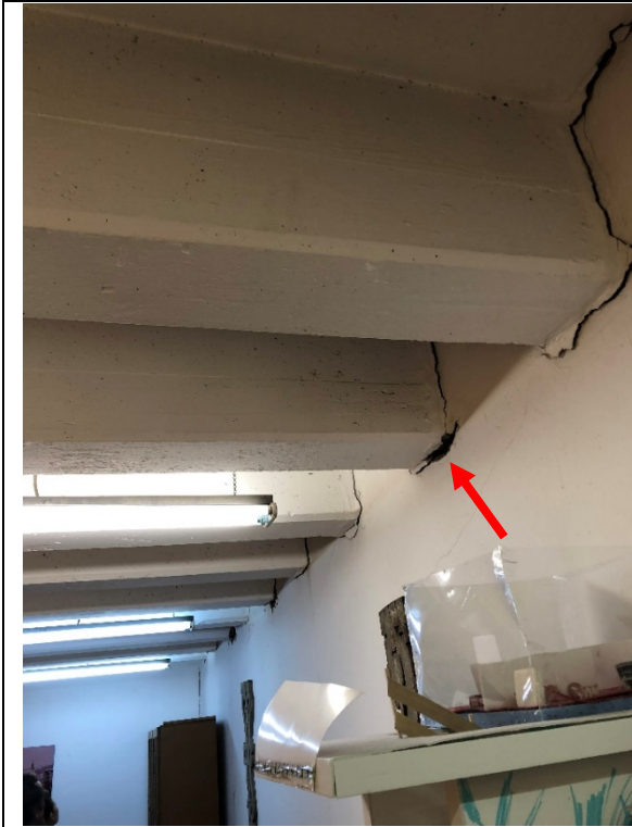
Şekil 7. Restorasyon Anabilim Dalı betonarme kirişli döşeme ile yığma duvar arasında meydana gelen çatlaklar.
