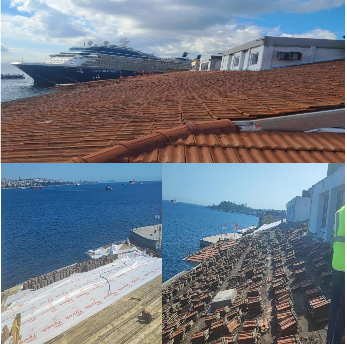
Mimarlık Fakültesi Binası Güçlendirme ve Restorasyonu Projesinden Çalışmalar
