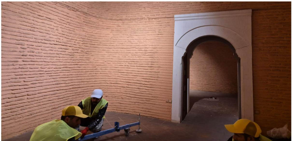
Tophane-i Amire Kültür ve Sanat Merkezi Çevre Düzenlemesi Projesinden Çalışmalar
