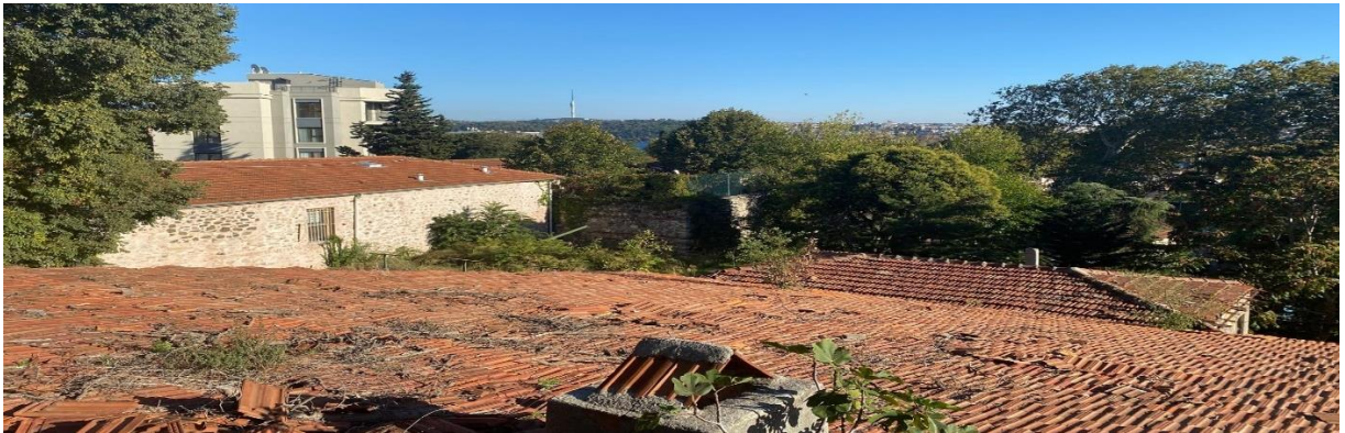
Dolmabahçe Yerleşkesi Restorasyonu Projesinden Çalışmalar
