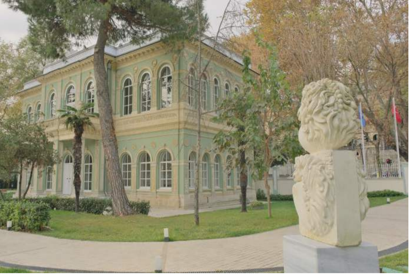
Restorasyonu tamamlanan Tophane Kasrı
