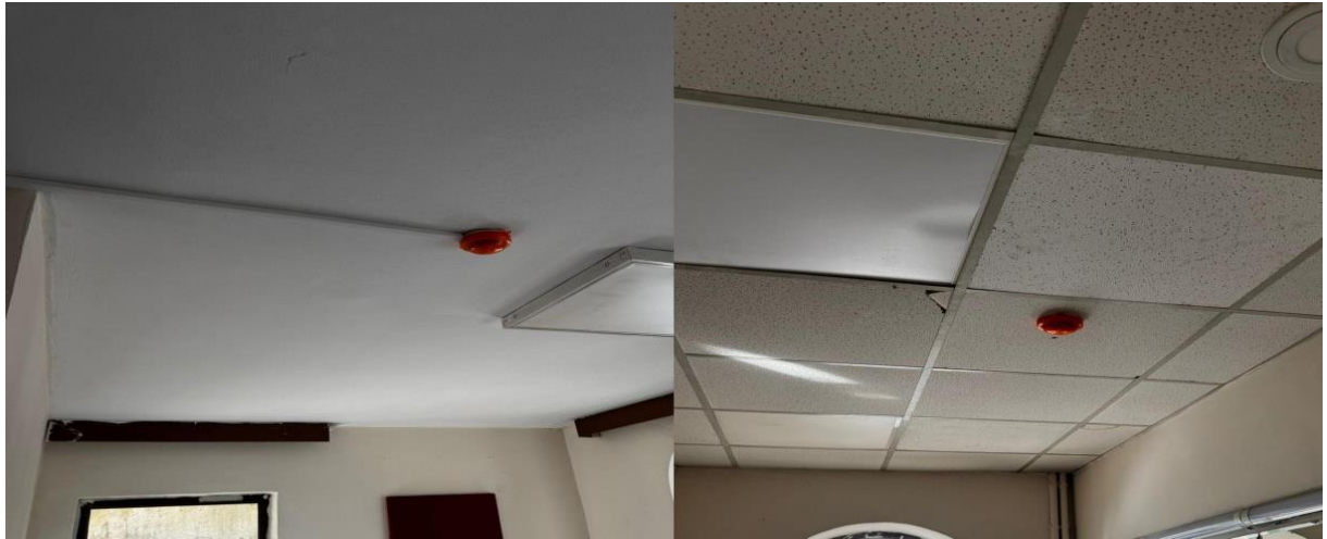
Dolmabahçe Yerleşkesi Restorasyonu Projesinden Çalışmalar
